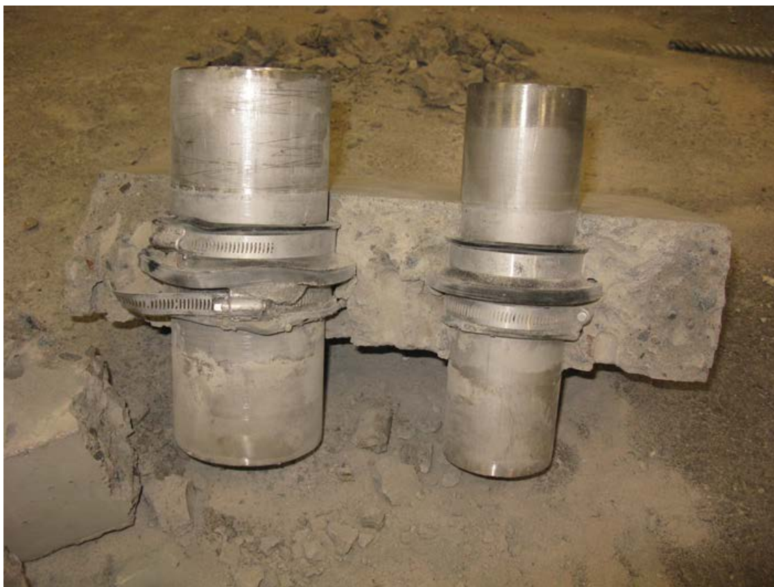
Bild 4: Provföremålets radontätning av gummiring typ IBECO radon- & vattentätningar LT vid destruktionskontroll efter avslutat prov.
